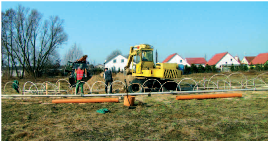
Roboty ziemne w miejscowości Modrzyca (fot. www.mzqkns-projekt.pl )
